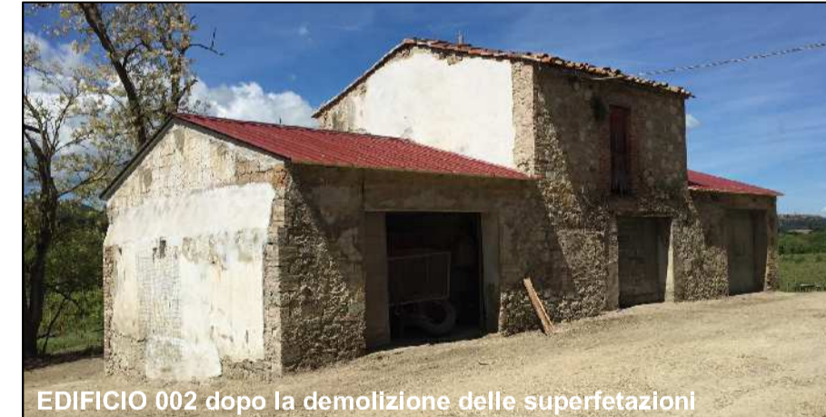
EDIFICIO 002 dopo la demolizione delle superfetazioni
